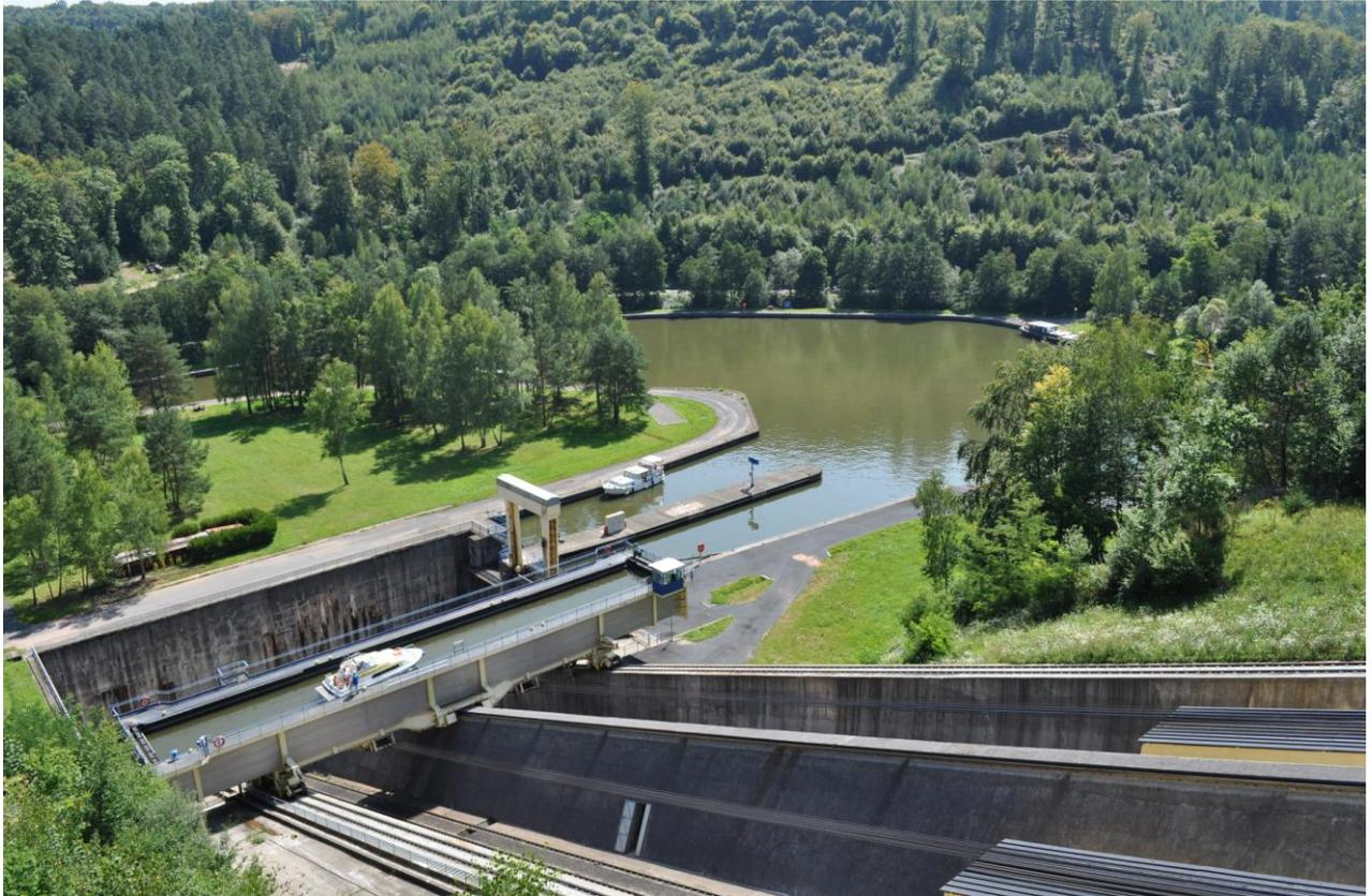
Dieses beeindruckende Bauwerk erlaubt es den Schiffen einen Höhenunterschied von 44,5 m in nur knapp einer halben Stunde zu überwinden (die effektive „Liftfahrt“ dauert dabei nur rund 4 Minuten). Mit dieser 1969 in Betrieb genommenen Konstruktion konnten 17 Schleusen ausser Betrieb genommen werden. Zu Spitzenzeiten konnten bis zu 40 Frachtschiffe pro Tag befördert werden.
